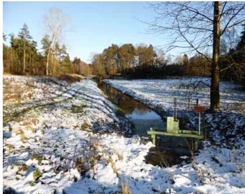
Als erste Maßnahmen sollen Entwässerungsgräben verschlossen und Wehre zurückgebaut werden. Foto: M. Hippke
